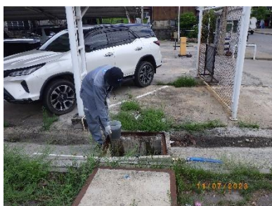
บ่อบำบัดน้ำทิ้งสุดท้ายก่อนระบายออกภายนอกโครงการ ข้างตลาด
